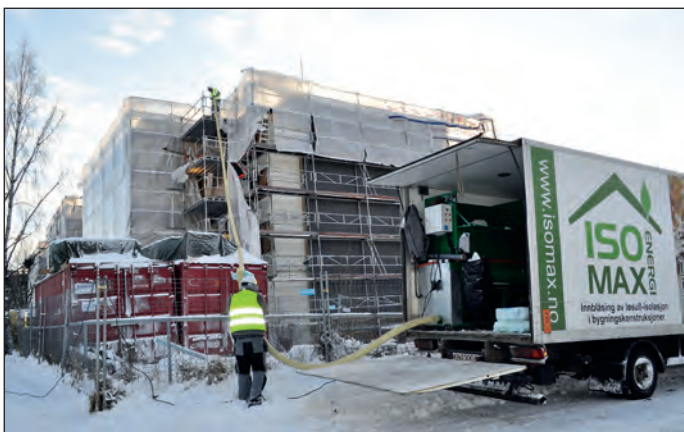
BLÅSTE. Multibbygg valgte å bruke blåseisolasjon fra Knauf Insulation og blåseentreprenøren Isomax Energi.
