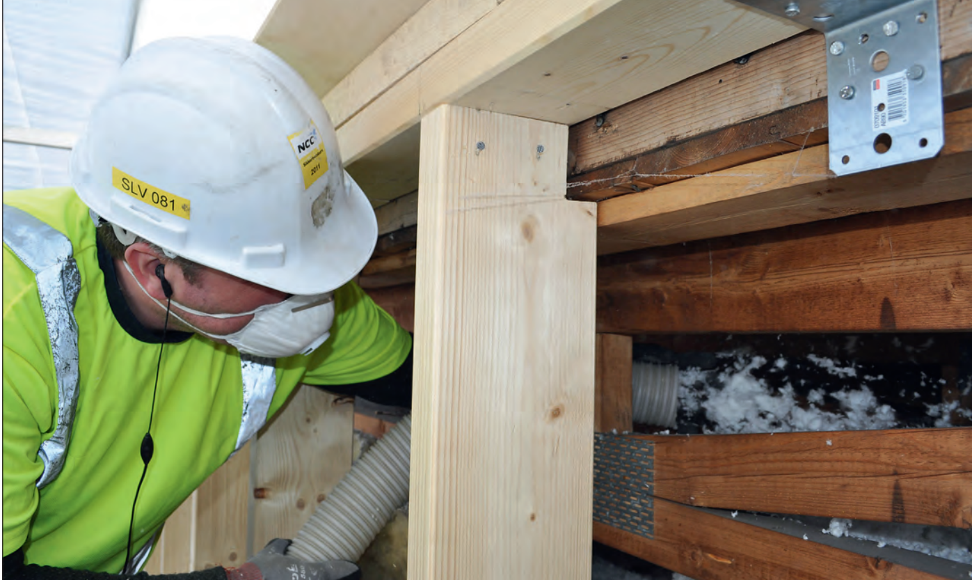
ISLOERING. Slåttevangen Borettslag i Oslo valgte å gå for blåseisolasjon da de skulle etterisolere.
